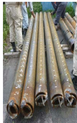
図1 構造計画(左)と施工に用いた鋼管杭(右)
