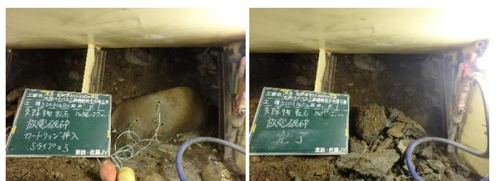
写真-6 玉石①放電破砕前
