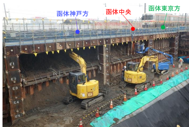
図7 3径間同時掘削の状況
