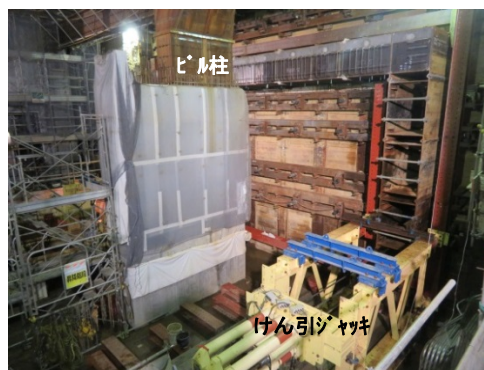
写真-3 到達立坑
