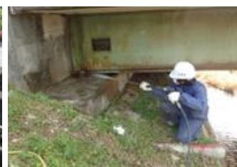
図-3 支承の清掃
