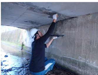
図-6 直営断面修復
