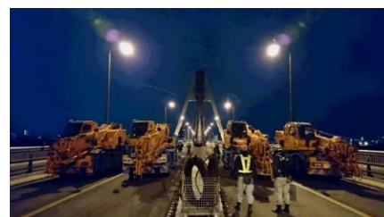
写-5 載荷試験状況
