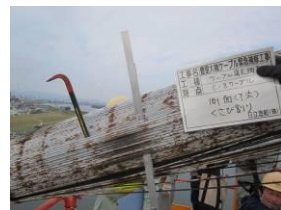
写-2 くさび割状況
