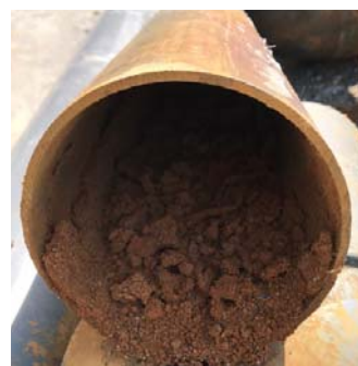
写真-1 地下水揚水時に使用した 塩ビ管(内部に鉄化合物が固着)
