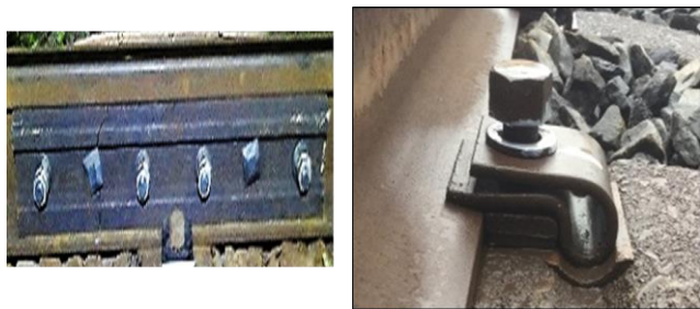
図1 継目板ボルト (左) 締結装置 (右)
