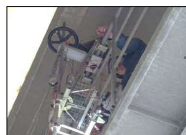
写真-4 現地試行（操作状況）
