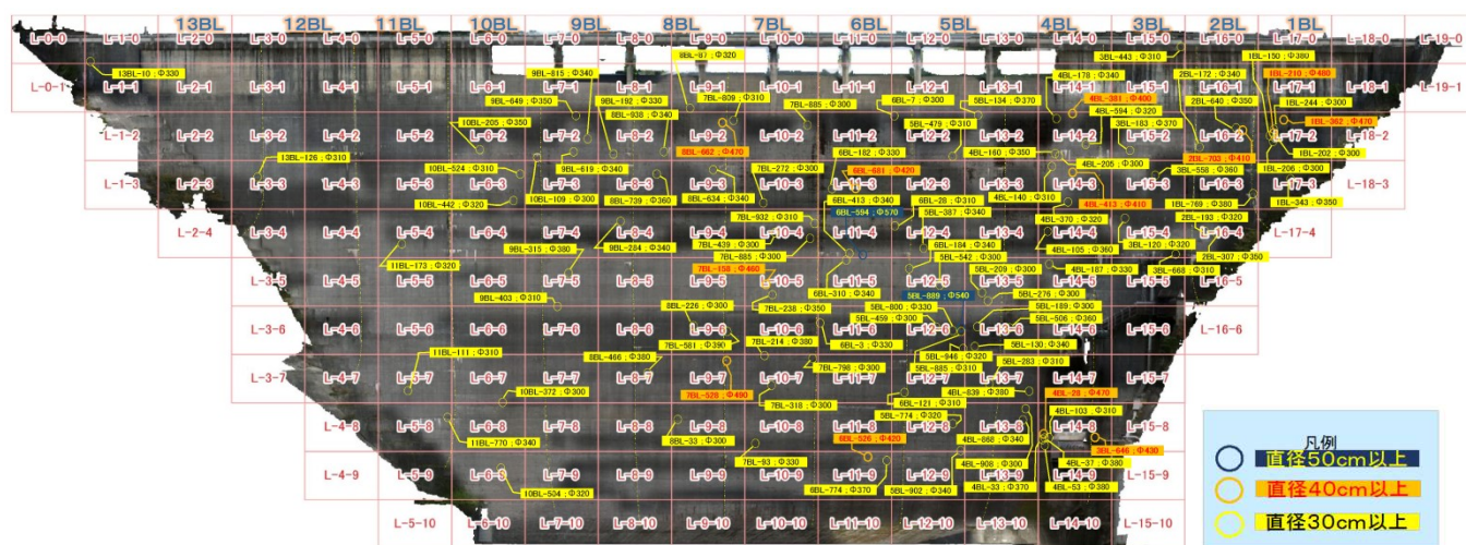
図3 鳴子ダム の 3 次元データから作成した正対画像（黄色や橙色の札は検出したポップアウト情報）
