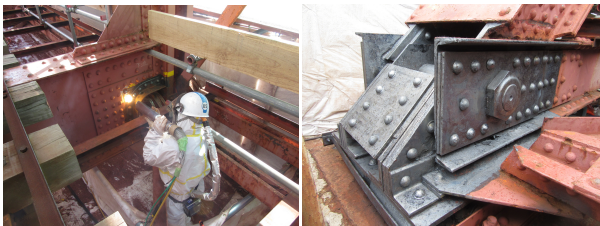
(a) 作業状況 (b) ケレン完了
