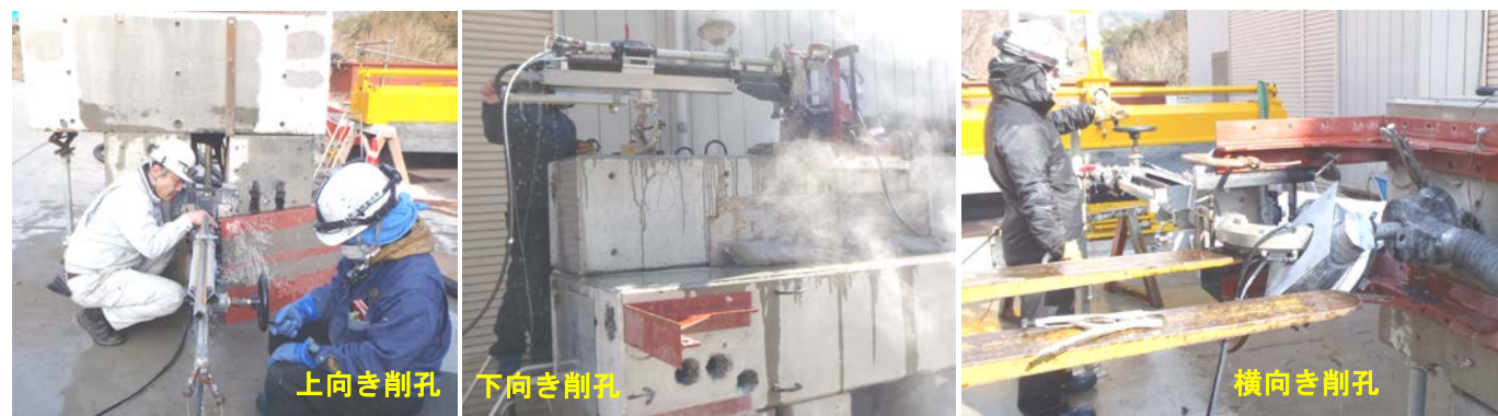
図-7 WJ曲り削孔実験状況
