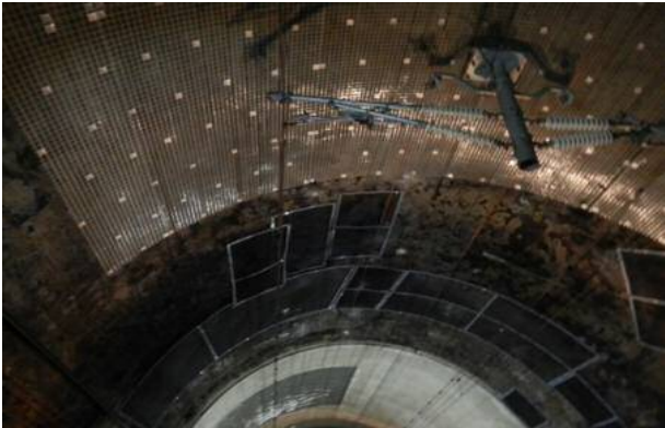
写真-3 トゥメッシュ工法による剥落対策
