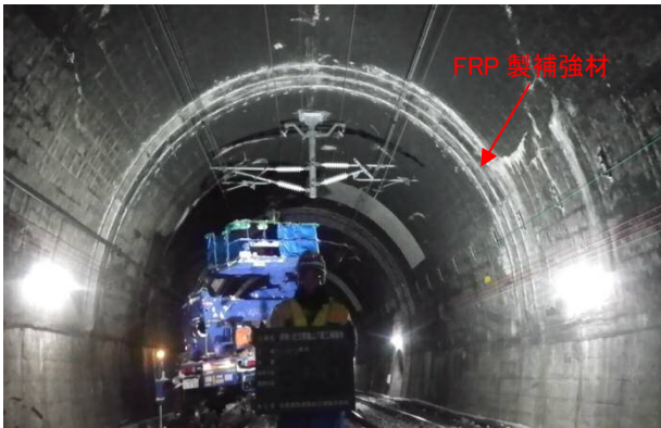
写真-4 FRP 帯板接着工法による覆工補強
