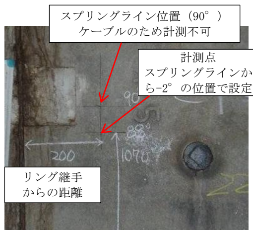
図1 計測点の設置の例
