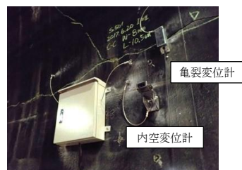
図6 計測機器設置状況
