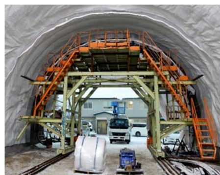
写真-4 模擬トンネル内 試験工事全景
