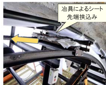
写真-3 ロール状シート巻上げ状況
