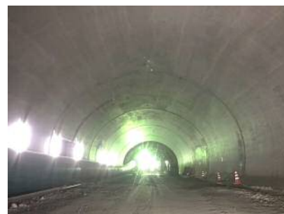
写真-1 覆工仕上がり状況
