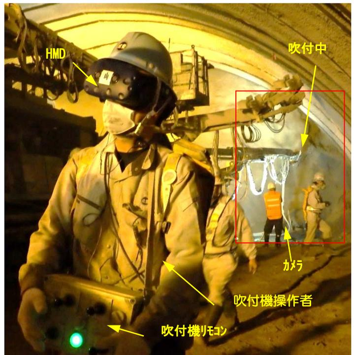
図-7 HMD 装着下の吹付作業状況
