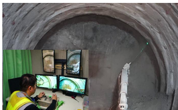
写真-5 上半における遠隔吹付け状況
