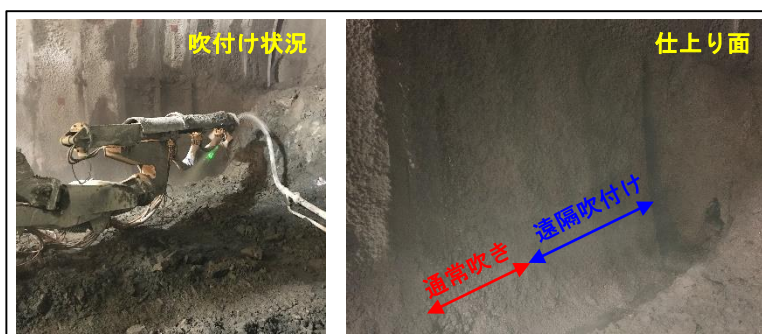
写真-4 下半における遠隔吹付け状況
