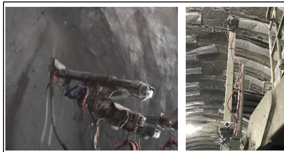
写真-2 レーザー照射とステレオカメラ設置状況
