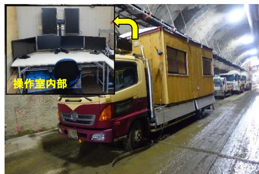
写真-3 遠隔操吹付け用操作室
