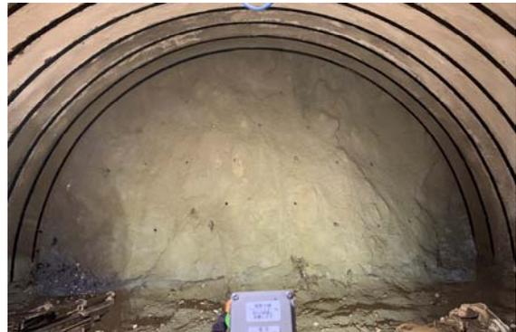
図-1 吹付けコンクリートに覆われた切羽
