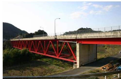
写真-1 対象橋梁側面
