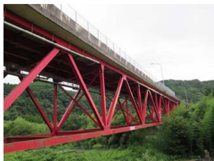
写真-1 調査対象橋梁の外観
