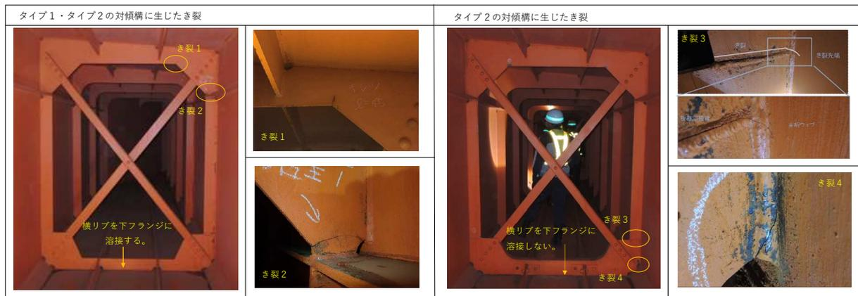
写真1 ダイヤフラム付近に生じたき裂（タイプ1・タイプ2）
