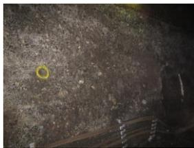
写真-2 コンクリートの粉体化
