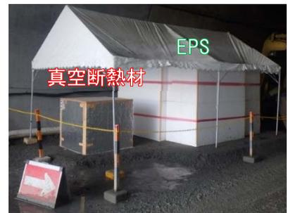
写真-1 試験施工における養生状況
