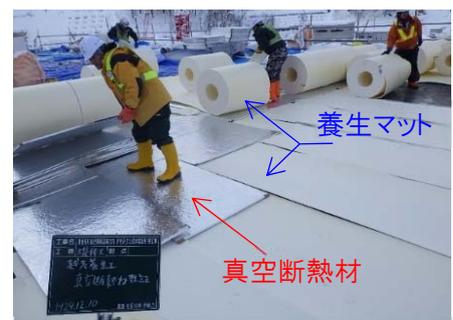
写真-2 真空断熱材の敷設状況
