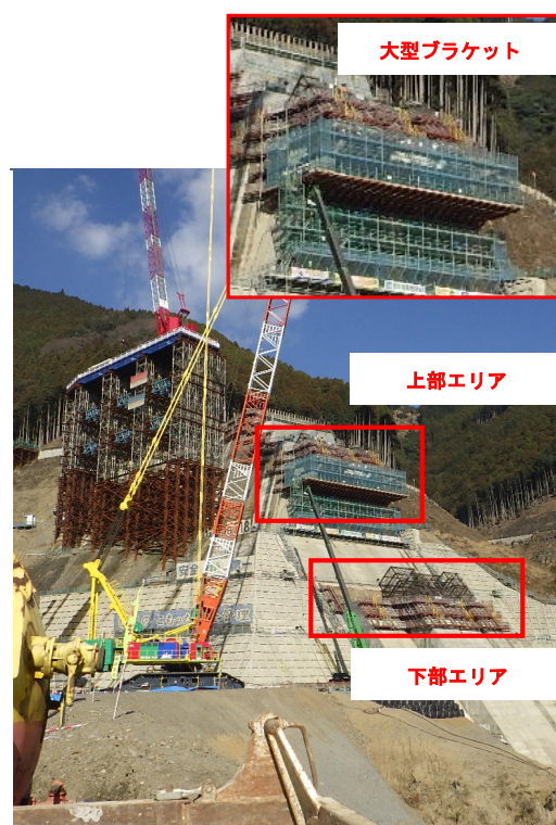
写真-3 上下2分割施工
