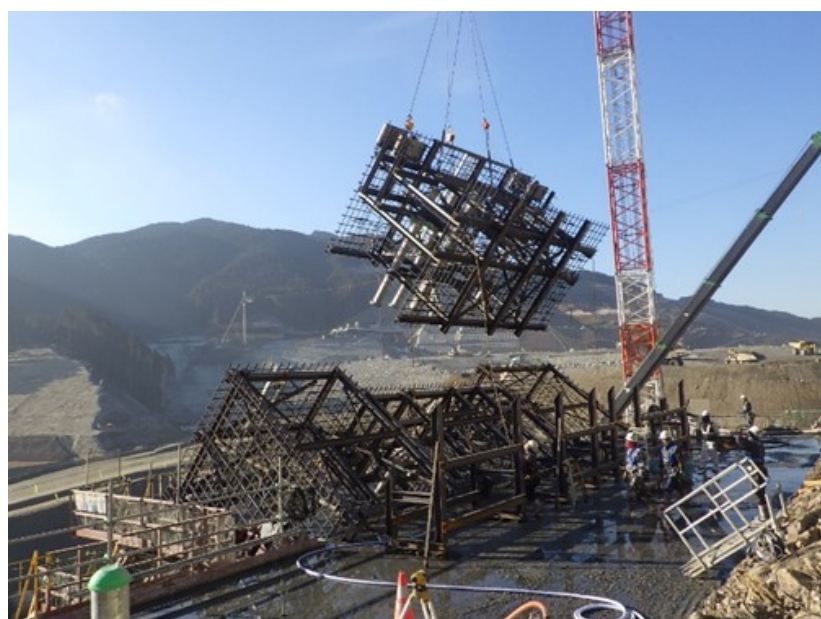
写真-2 鉄筋ユニット吊り込み
