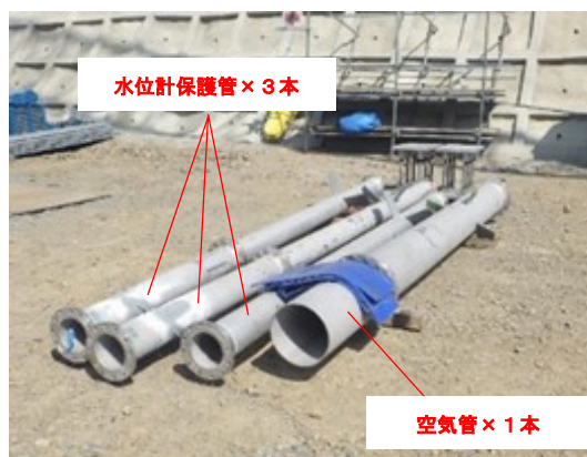
写真-1 取水ゲート金物 (水位計保護管, 空気管)
