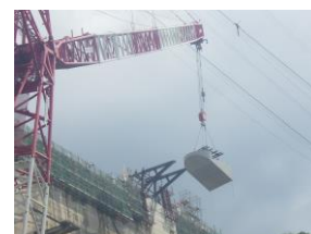
図-10 ブラケット架台への設置状況
