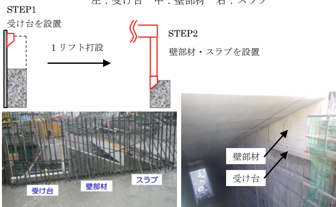
図-3 施工ステップおよび施工状況
