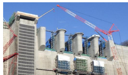
図-4 橋脚および橋台
