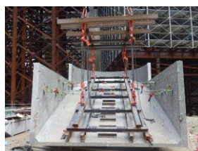
図-9 吊上げ状況
