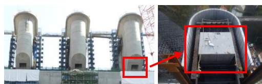
図-7 橋脚内部の中空断面
