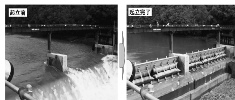
写真-1 可倒堰の運用
