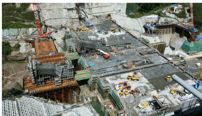
図-5 堤内構造物の多い中での巡航 RCD 施工状況 (常用洪水吐による左右岸分断)
