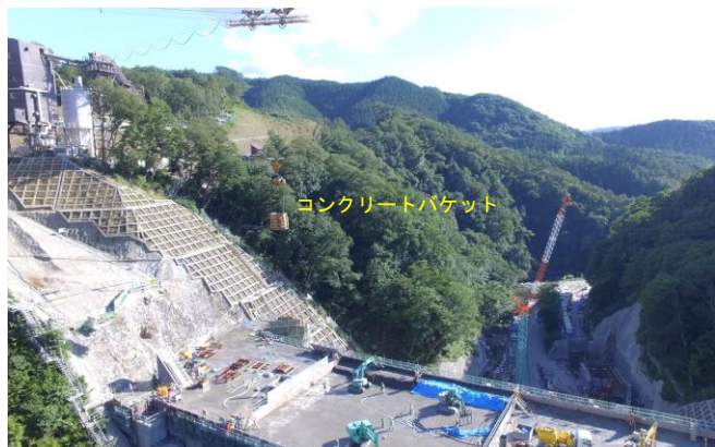
図-4 コンクリート運搬状況
