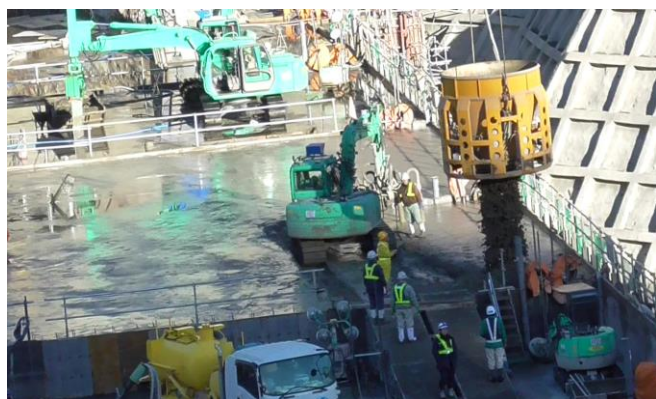
図-5 コンクリート打設状況
