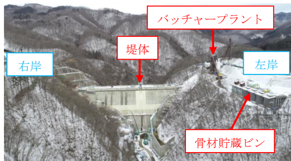
図-1 築川ダム全景
