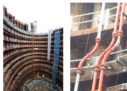
写真-1 配管設置状況
