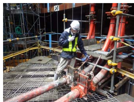
写真-2 シャッター式バルブ
