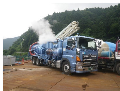
写真-4 超高压バキューム車
