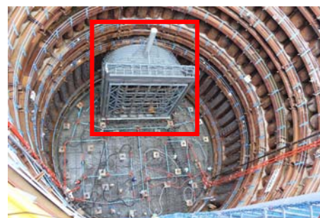
写真-3 分岐配管設置状況
