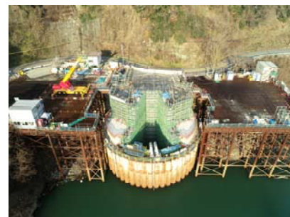
写真-5 全景写真
