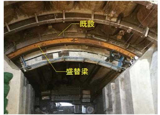
図-4 盛替梁（立坑上部より臨む）
