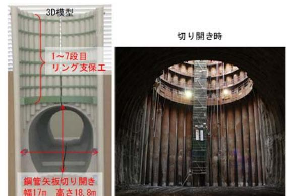
図-2 呑口立坑切り開き部(躯体構築前)
