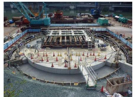
写真-9 頂版コンクリート打設完了
