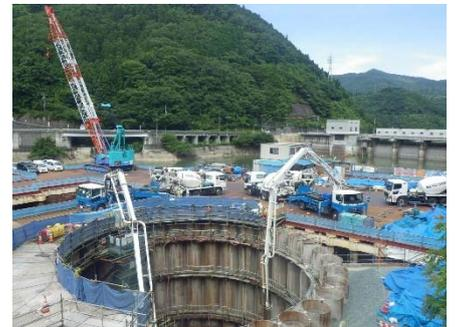
写真-6 コンクリート打設状況
