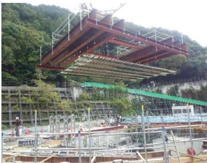
写真-7 吊り支保工設置状況
