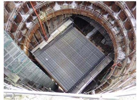
写真-3 ベルマウス管鉄筋組立
