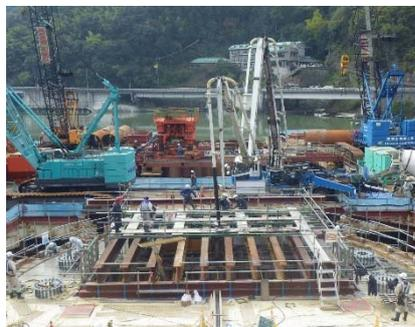
写真-8 頂版コンクリート打設状況
