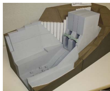
写真-1 減勢工および吐口部完成予想模型
