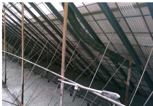
写真-4 バイブレータ挿入ガイド設置状況
