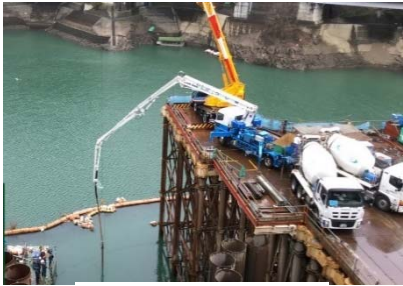
写真-3 打設状況
