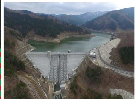
写真-1 試験湛水状況
