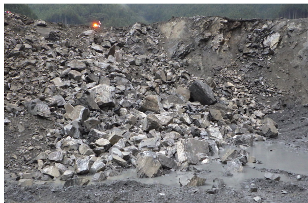
写真-1 発破後の切羽の外観 (岩種判別が困難な例)
