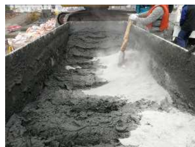
写真-1 吸水性改質材投入状況
