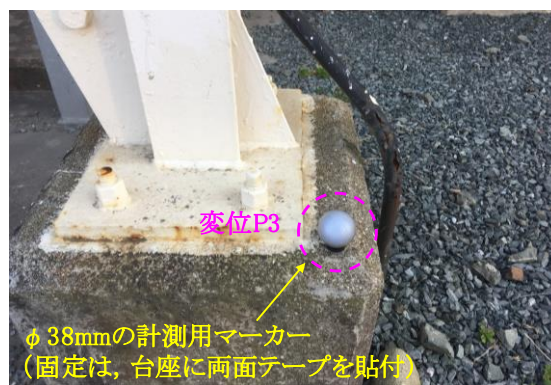
写真-2 基礎に貼り付けたマーカー
