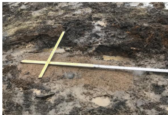
写真-3 No. 1 の杭頭 (施工後)
