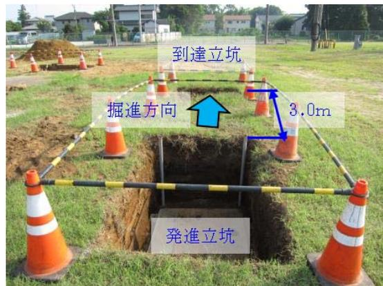
写真-2 性能検証試験の発進立坑 (粘性土)
