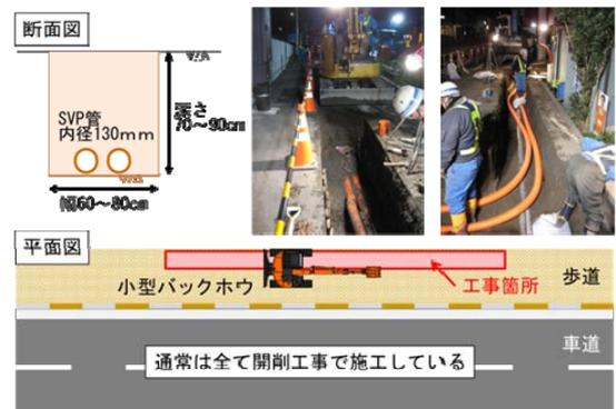
図-1 宅内引き込み管施工の一例
