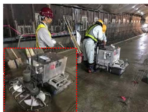
写真-5 仕上げロボットの使用状況
