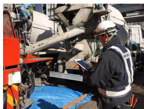
写真-6 打設管理システムの使用状況
