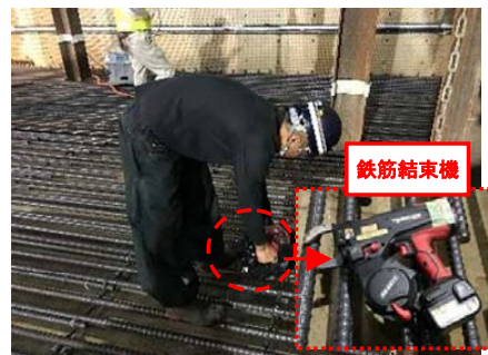
写真-1 鉄筋結束機の使用状況
