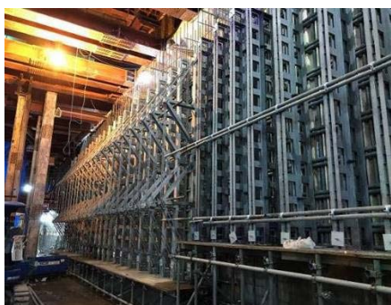
写真-2 大型枠支持材の設置状況
