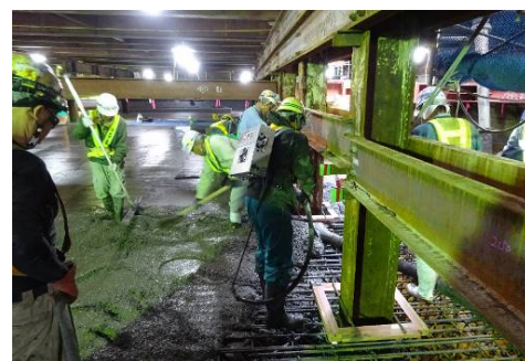
写真-4 背負い式コードレスバイブレータ
