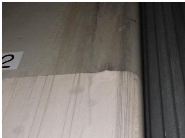
写真-1 フィルム上端の剥がれ箇所の橋脚漏水跡
