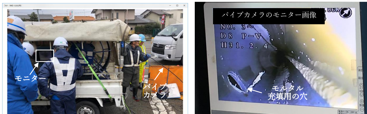
図 3. パイプカメラによる管路削孔状況の確認
