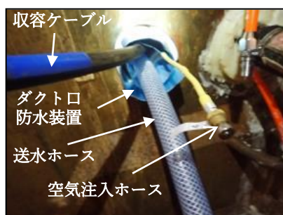
図 1. 光ケーブル 1 条収容時
