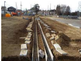
写真-8 施工後のトラフ内部
