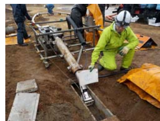
写真-2 トラフ内砂除去状況
