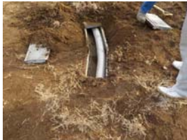
写真-7 曲線部(3mR) 状況
