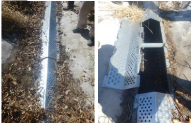
写真-5 屋根付き角型 U 字溝
