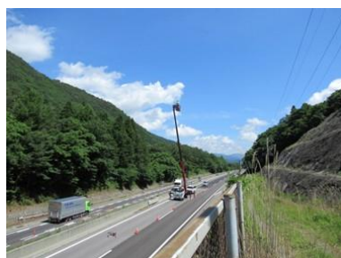
写真-2 赤外線調査実施状況
