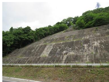
写真-1 切土吹付コンクリート
