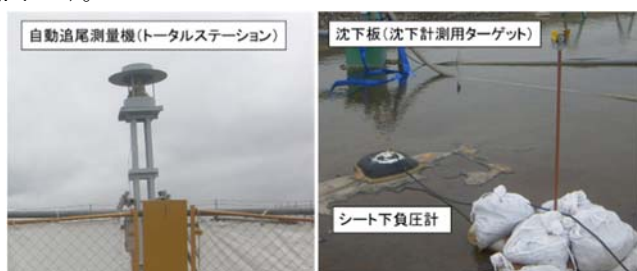
写真-2 自動追尾測量機および沈下板
