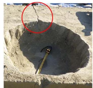
写真-2 クラック箇所の試掘 (層厚 50cm ②)
