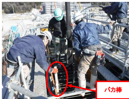
写真-1 バカ棒を用いた層厚管理状況
