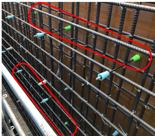
写真-3 型枠への蛍光 P コン設置状況
