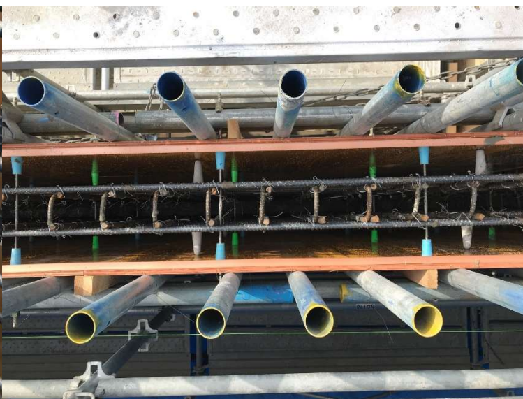
写真-4 上部から型枠内を覗いた状況
