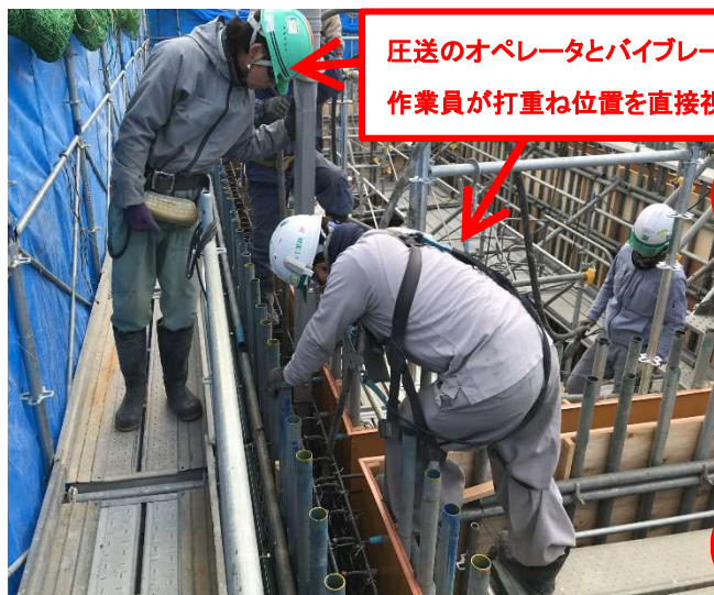
写真-5 コンクリートの打設状況
